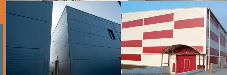
Cubierta | Panel Sandwich Tapajuntas | Panel Sandwich 3 grecas
